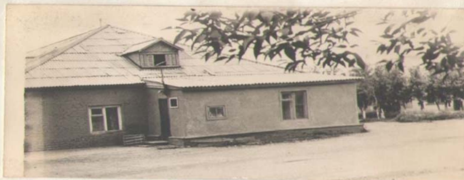
Здание детской музыкальной школы в г. Новоульяновске июль 1972г.
